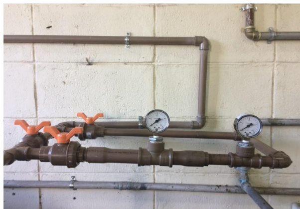
(Figura 7- Tubo de Venturi)
