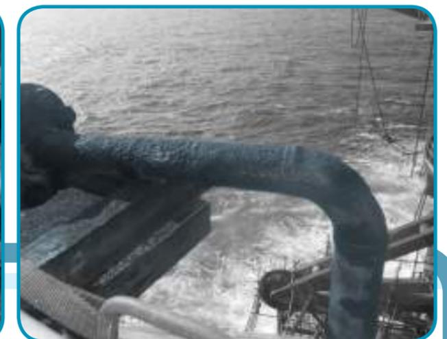
**Figura 1** > Exemplos de corrosão em tubulação numa plataforma *offshore*.
