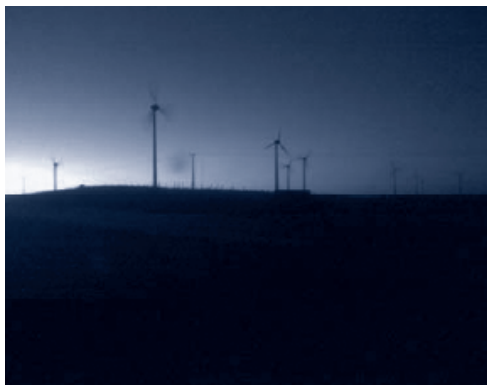
Parque eólico em Água Doce - SC Foto: Fernando Dalmaz
