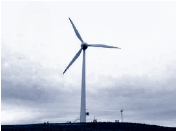
Figura 9. Aerogerador em Bom Jardim da Serra, 600 kW, diâmetro de 44 metros. Foto: Júlio César Passos
